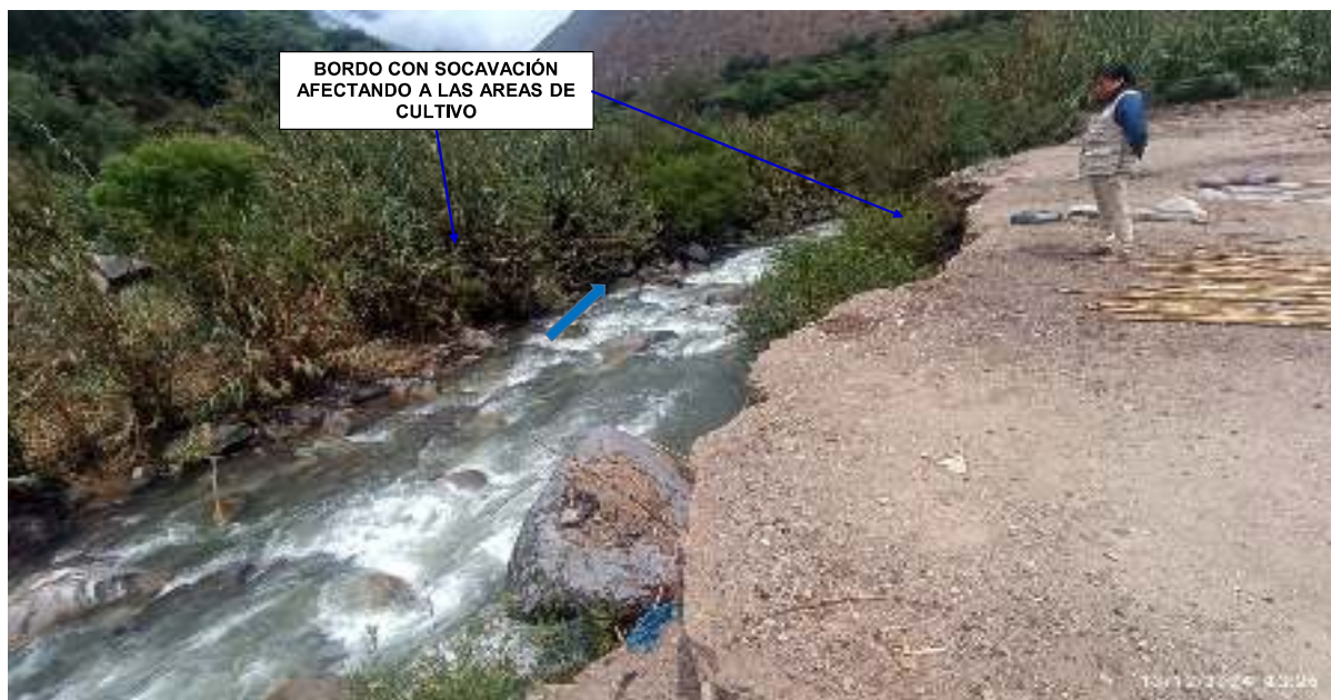
FIGURA N°03: TRAMO PUENTE ACOS - RIO CHANCAY HUARAL CON BORDOS EROSIONADOS, PONIENDO EN PELIGRO A LAS AREAS DE CULTIVO, REQUIERE LIMPIEZA Y CONFORMACION DE DIQUES CON MATERIAL PROPIO.
