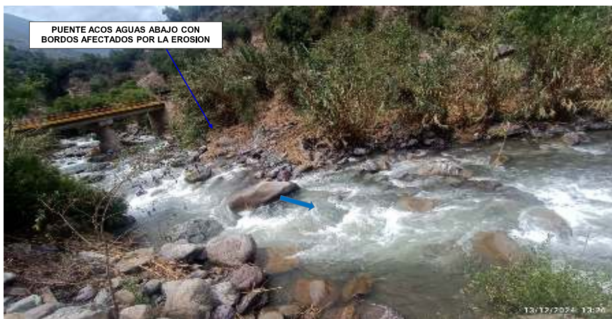
FIGURA N°02: CAUCE CON PRESENCIA DE ROCAS DE DIFERENTES TAMAÑOS EN EL RIO CÁRAC, SECTOR PUENTE ACOS - RIO CHANCAY HUARAL, CAUSANDO EROSION EN AMBOS BORDOS DEL RIO.
