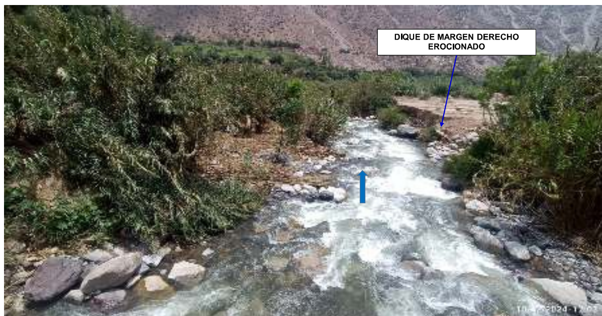
FIGURA N°01: TRAMO CRÍTICO POR EROSION PLUVIAL EN EL RIO CÁRAC, EN EL SECTOR PUENTE ACOS - RIO CHANCAY HUARAL, DISTRITO DE SAN MIGUEL DE ACOS, PROVINCIA DE HUARAL - LIMA.
